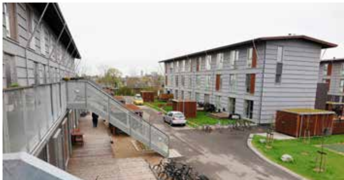
Die Siedlung Sundbygård ist ein Beispiel für einfaches, vorgefertigtes Bauen.
