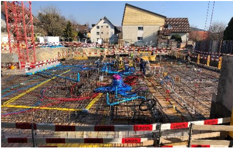
Bodenplatte EG März 2022
