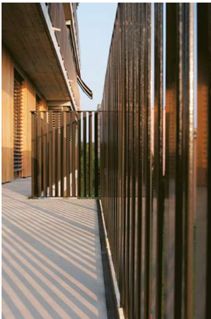
Balkongeländer sollten sowohl Schutz vor Einblick gewähren als auch einen Ausblick nach aussen ermöglichen.
