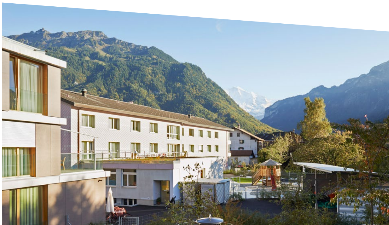
Das ungenutzte ehemalige Heim-Gebäude mit Alterswohnungen und Kita.
