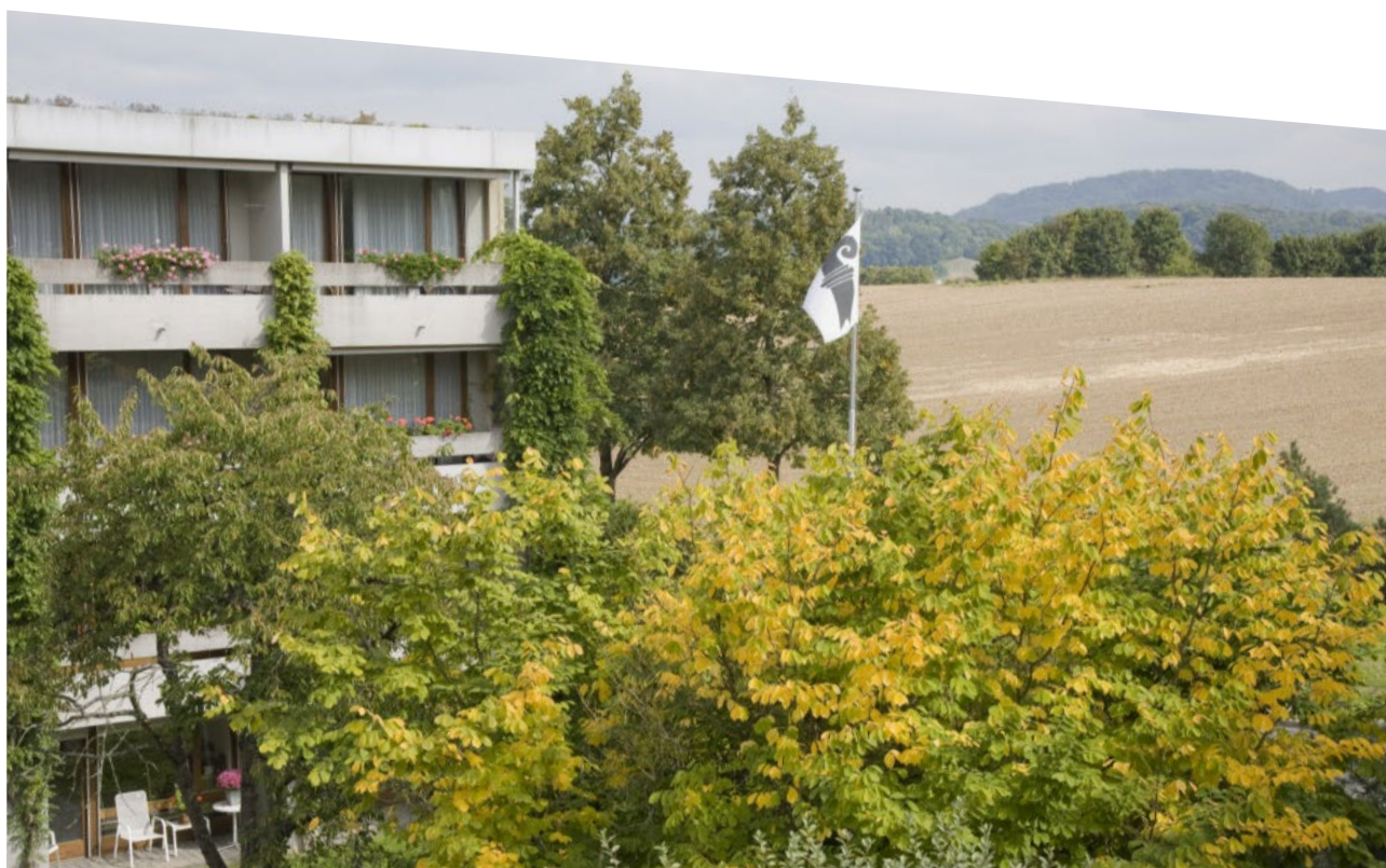
Das Betagtenzentrum Zum Wasserturm liegt am Stadtrand von Basel.
