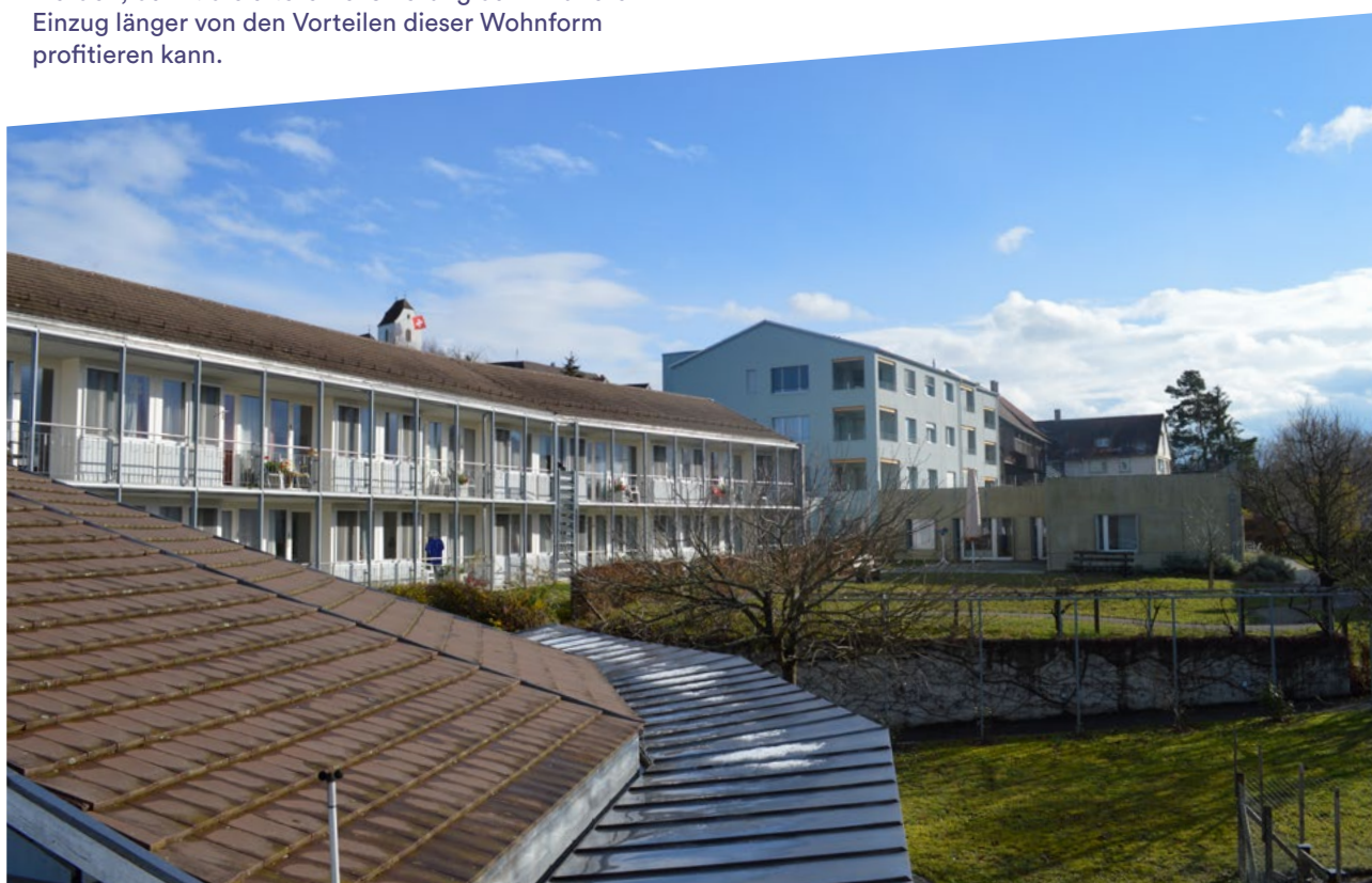
Im Vordergrund der ältere Heimbau. Im Hintergrund: Mehrzweckraum und Neubau.
