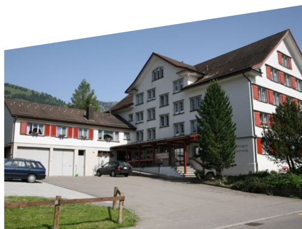
Der Zugang zum ehemaligen Bürgerheim ist mit einer Rampe hindernisfrei erschlossen.
