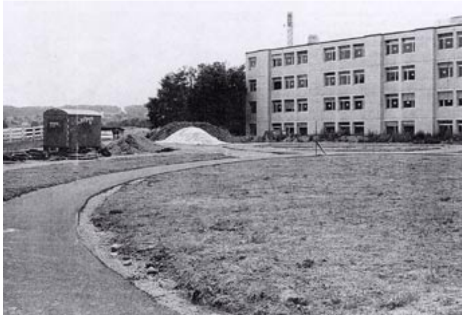
Auf dem «Reusspark»-Areal, zwischen dem Krankenhaus-Hauptgebäude und der Reuss, zeigen sich die ersten Konturen des neuen geschützten Spaziergartens.
