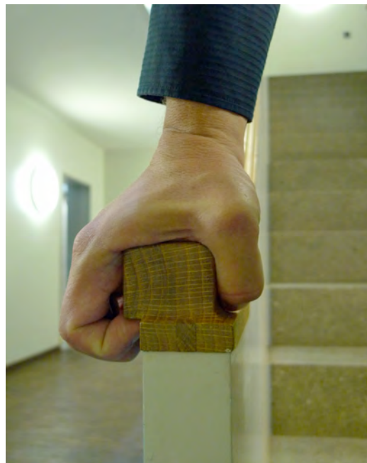
Das Festhalten ist bei einem aufgesetzten Profil nur begrenzt möglich
