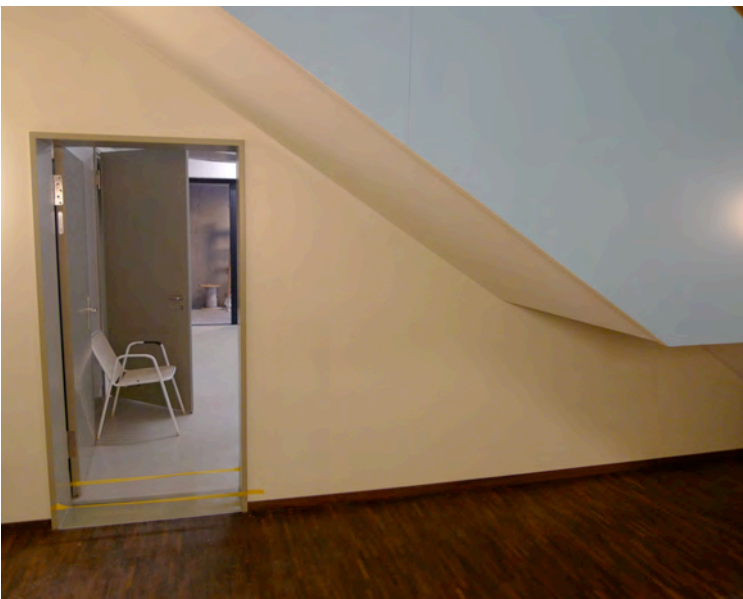
Verletzungsgefahr beim Austritt aus der Tür Richtung Lift
