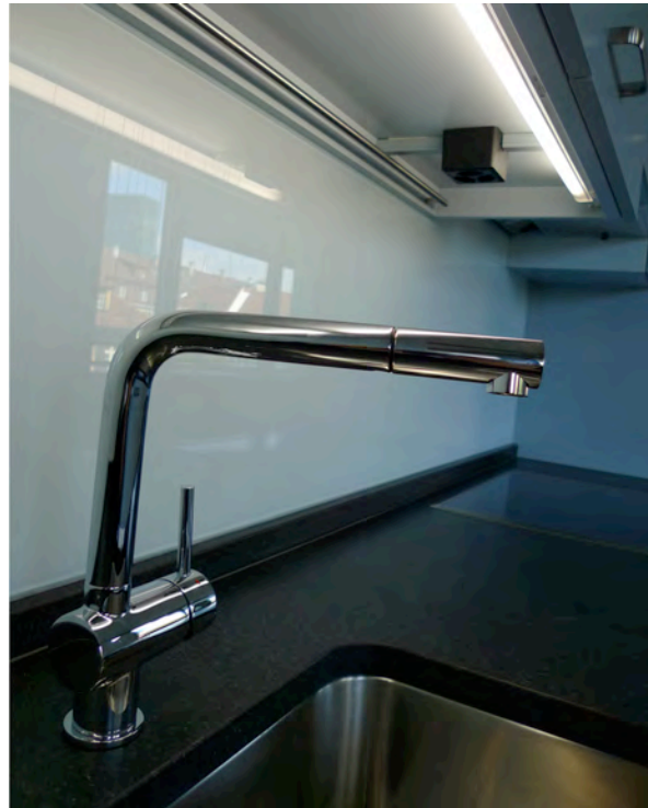
Schwer auffindbare und nutzbare Steckdose unter den Oberschränken
