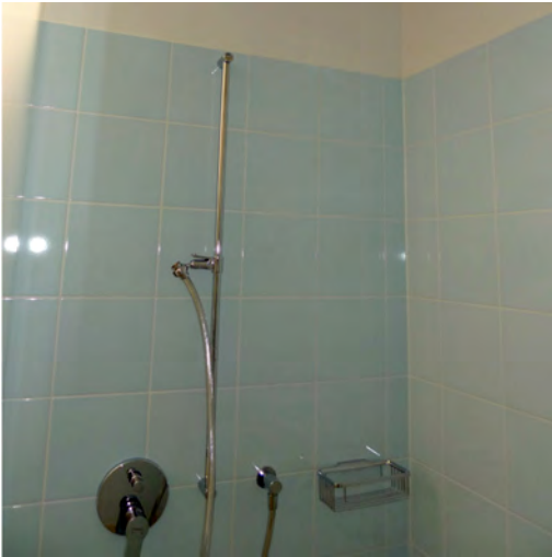
ungenügend verankerte Duschgleitstange (Mitte: Duschgleitstange von FSB in Haltegriffqualität mit ergonomischer Höhenverstellbarkeit)
