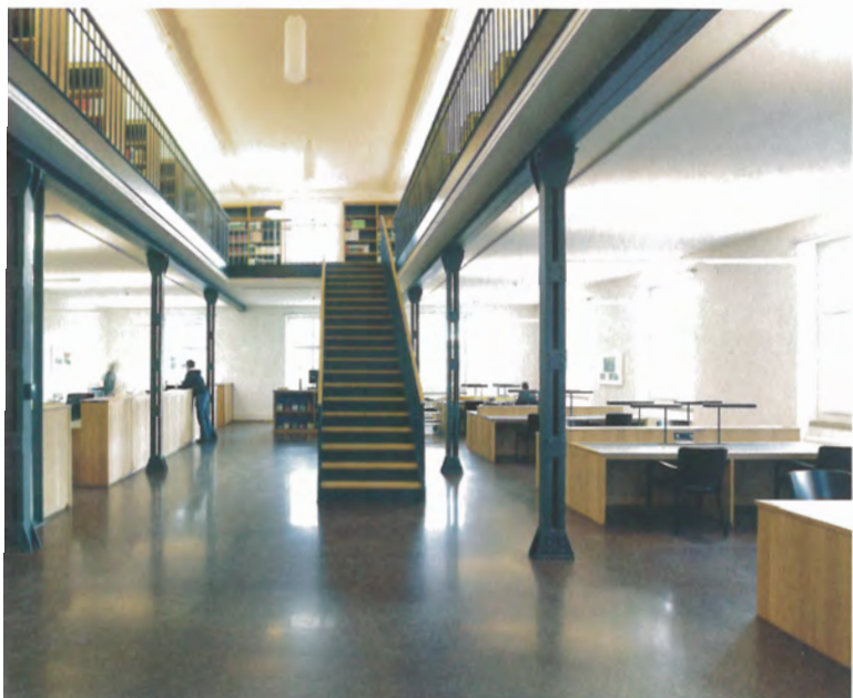
^ Lesesaal des Thurgauer Staatsarchivs in Frauenfeld: Die Stützen sind alt, der Deckeneinschnitt neu.
