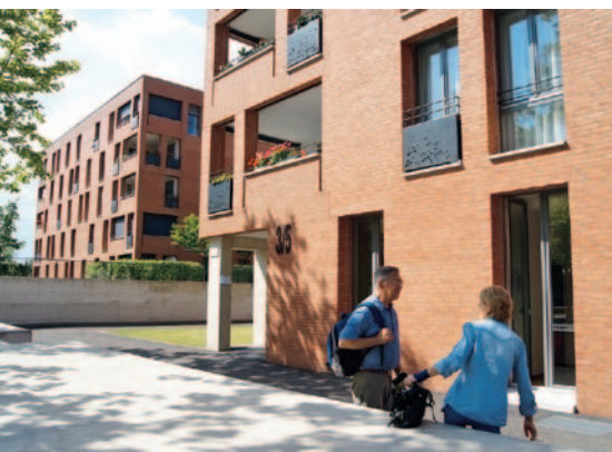
Blick in die ABZ-Siedlung Ruggächern mit dem 55+-Haus im Vordergrund.
