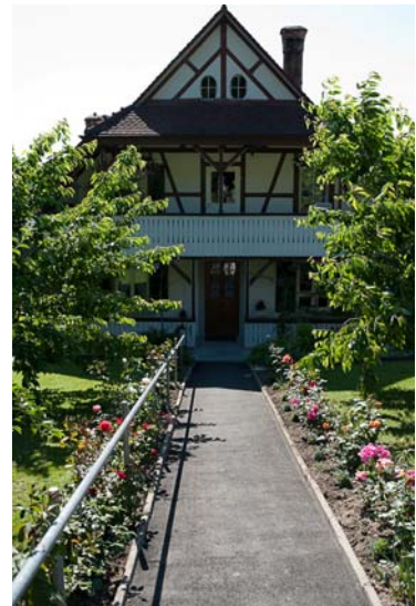
Der hindernisfreie Zugang zum umgebauten Einfamilienhaus – rollstuhlgängig mit Handlauf
