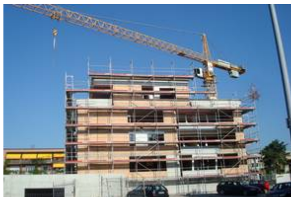
Abschluss des Rohbaus im Juli 2011
