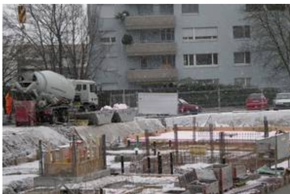
Einbau der Bodenplatte im Dezember 2010
