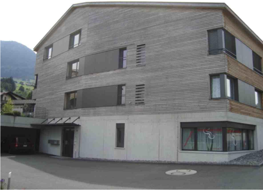
Westfassade mit Einfahrt Einstellhalle
