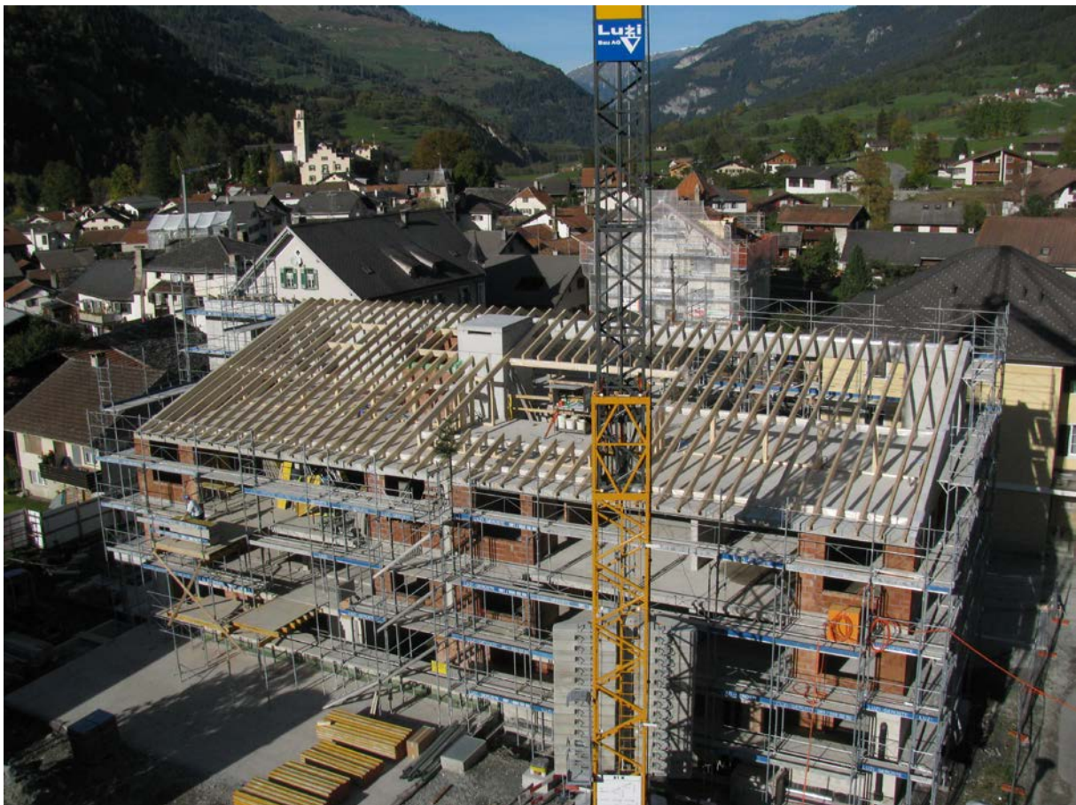
Projekt Colani in Andeer / GR ... Dach aufgerichtet
