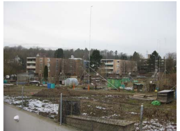
Soligänterstrasse 30 – 34 (Baubeginn 2011; Bezug 2013)
