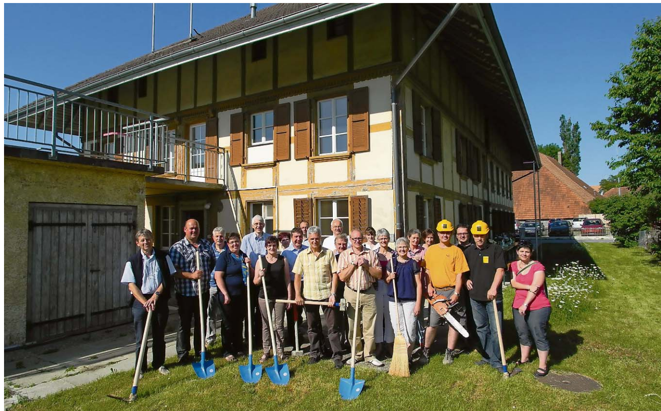
Die Beteiligten vor dem altherwürdigen Haus im Dorfzentrum, das innerhalb eines Jahres umgebaut wird.
