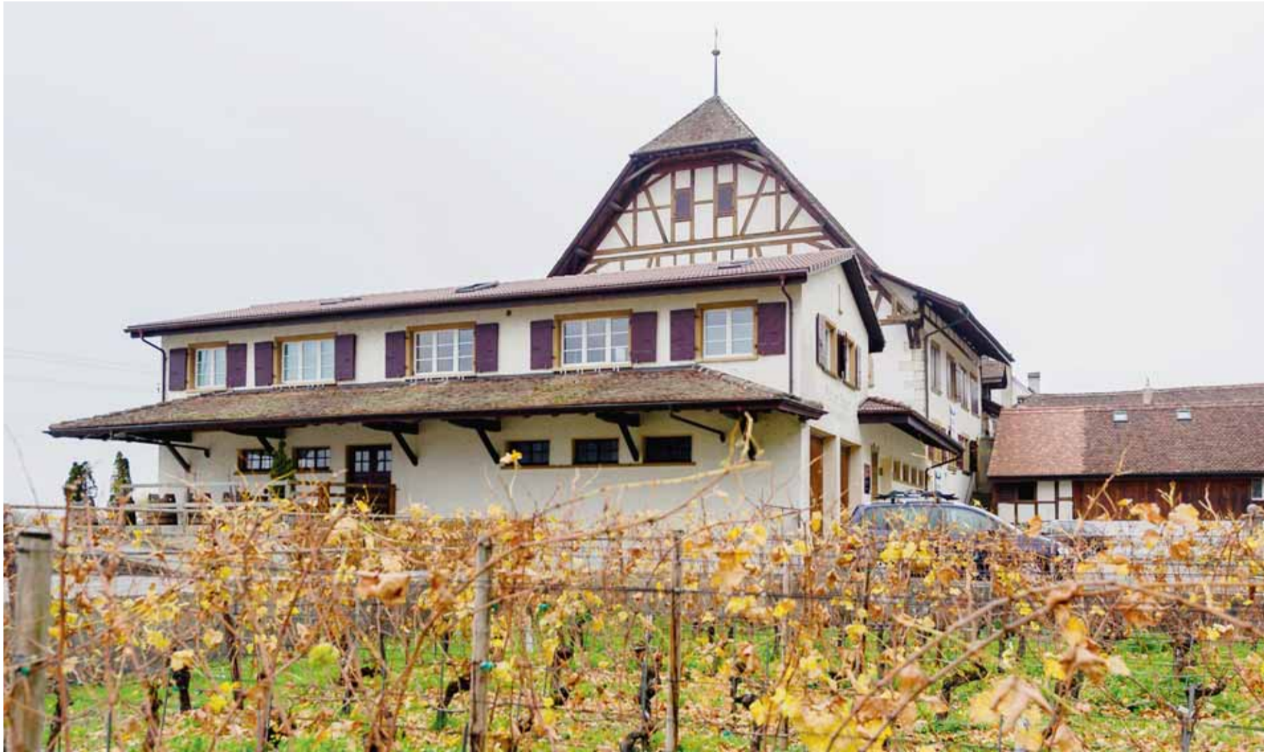
Im Engel-Haus entstehen neun Seniorenwohnungen auf drei Etagen sowie Räume für Kultur und Begegnung von Jung und Alt. Matthias Käser
