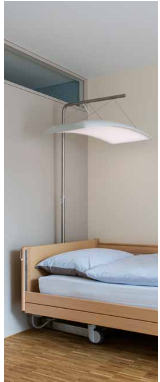
6 Dynamischer Dämmerungssimulator über dem Kopfende eines Bewohnerbettes (in Leselichtfunktion).
