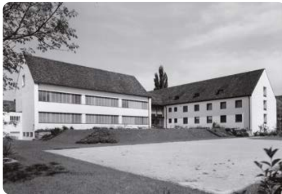
Die neuen Gebäude der Bäuerinnenschule der 1960er-Jahre umfassen einen einstöckigen Trakt (ganz links) sowie rechtwinklig zueinander angeordnet einen Schul- und einen Wohntrakt (mitte und rechts).
