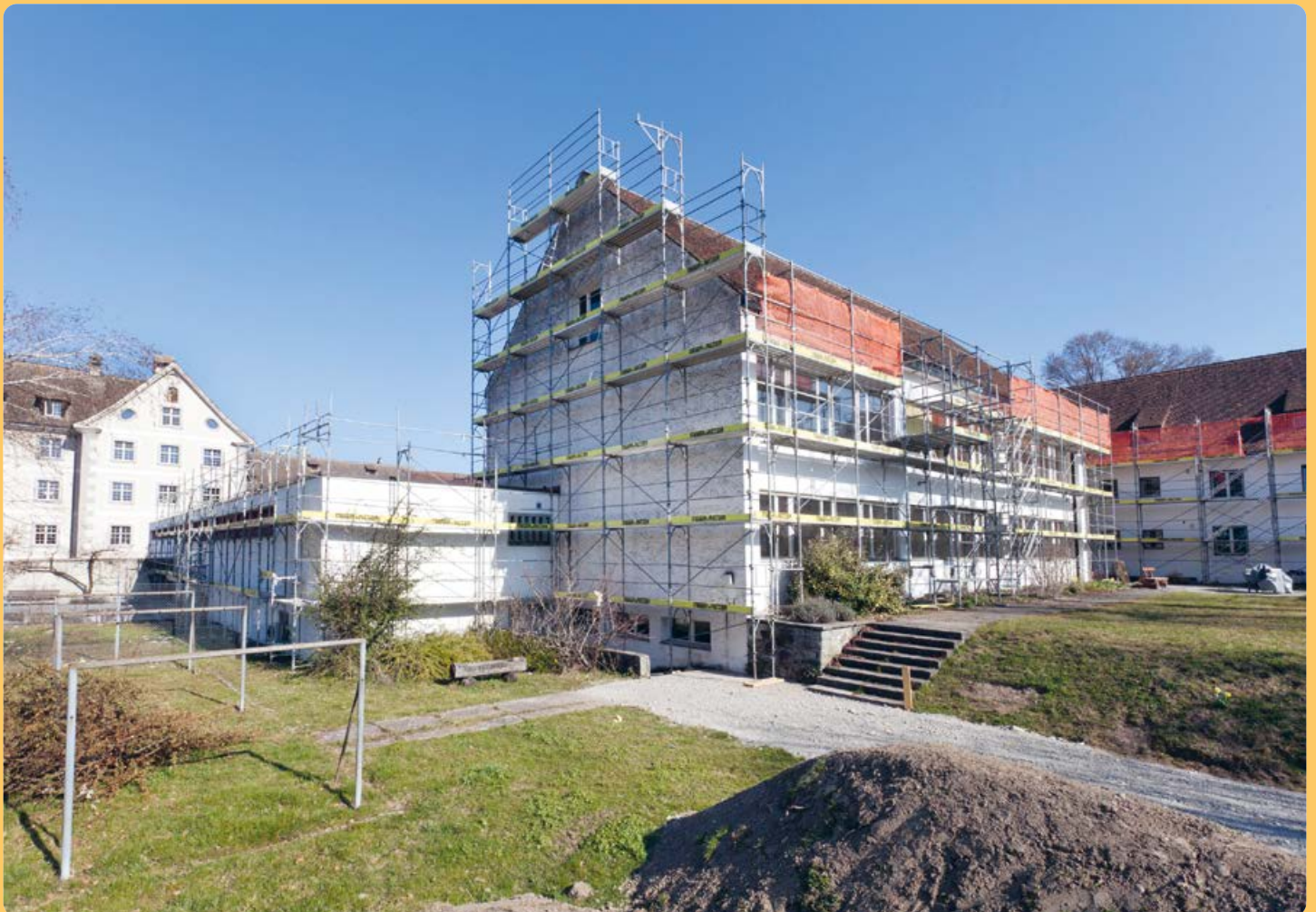
Umbau der ehemaligen Bäuerinnenschule 2022/23.
