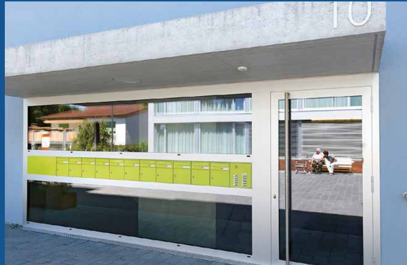
Familiäre Atmosphäre vor dem Haus der Pflege- wohngruppe (links), das sich im Haupteingang des Gebäudes gegenüber spiegelt (rechts). Die Neubau- ten flankieren den zentralen Platz der Siedlung.
