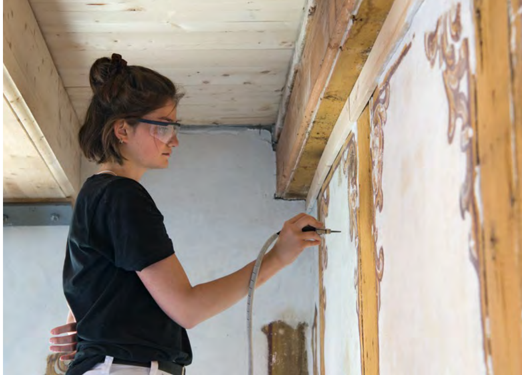
Bildstrecke: Restaurierungsarbeiten im denkmalgeschützten Engel Haus in Twann. Der Ort ist im ISOS verzeichnet.
