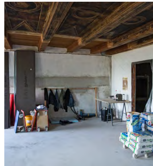
Ordentliche Baustelle im Engel Haus in Twann.
