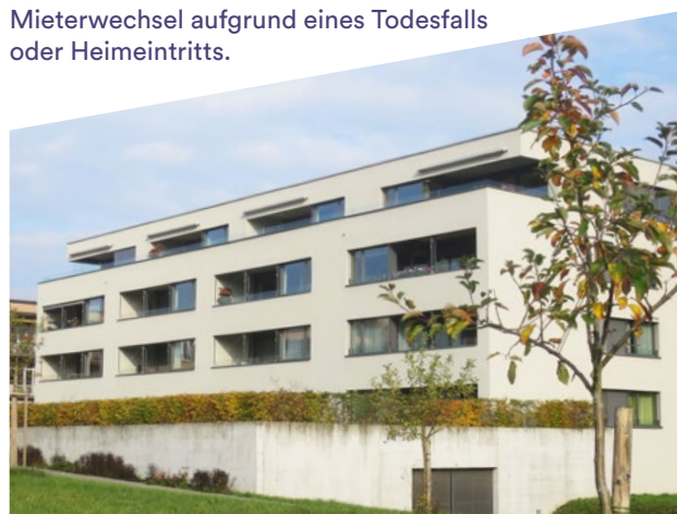
Südfassade der Alterswohnungen Hofwiesenstrasse in Dietlikon
