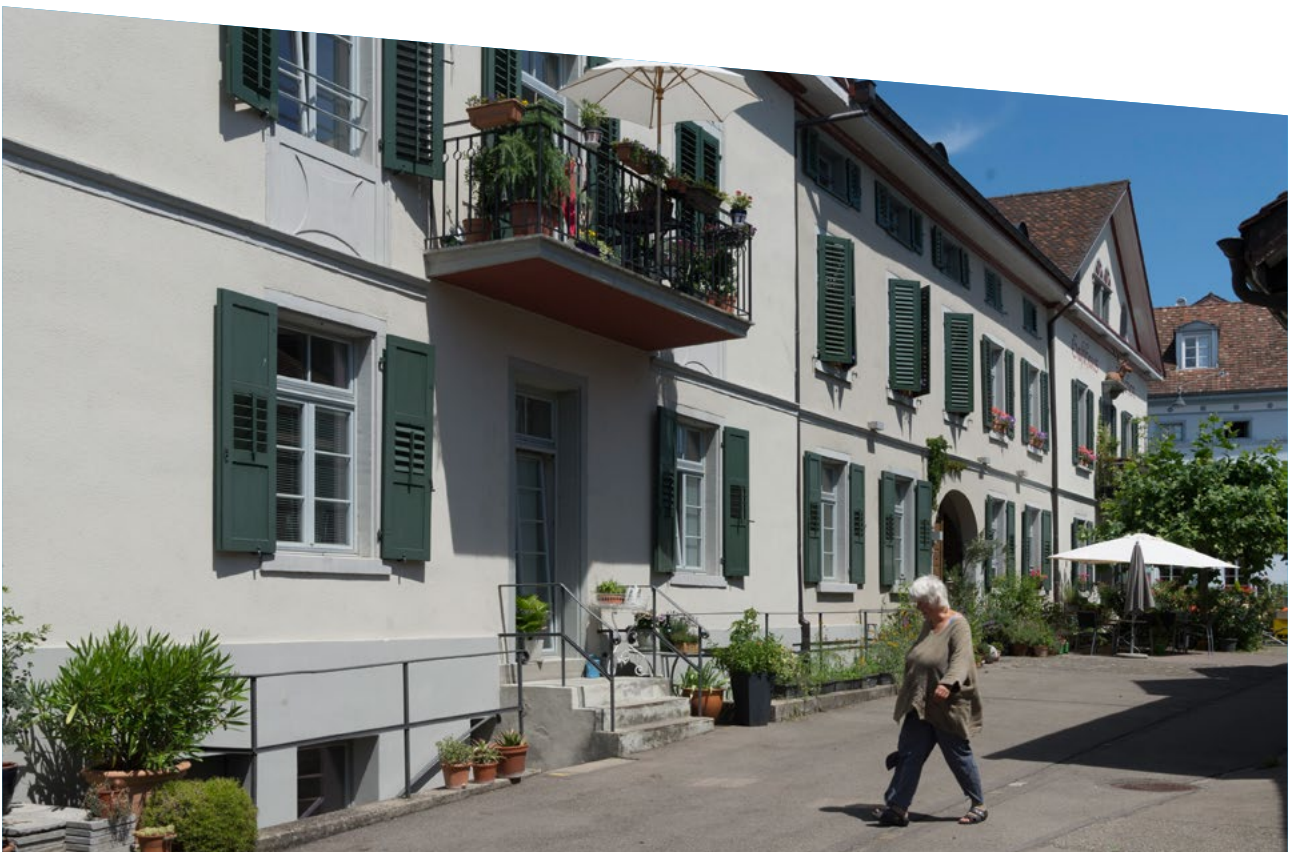
Das umgenutzte Gebäudeensemble in der Altstadt von Diessenhofen.
