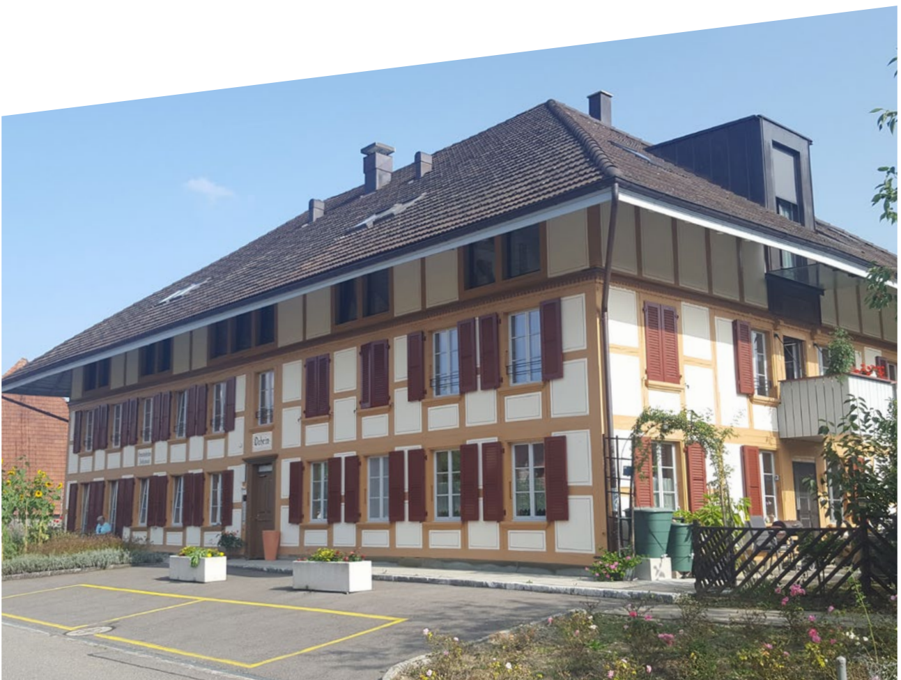
Das Gebäude wurde aussen kaum verändert, im Innern dagegen vollständig ausgehöhlt.
